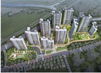
Cheonan Kukdong Starclass (Kukdong Construction)
