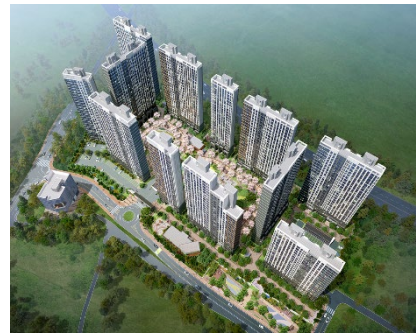
Gongdo Laporte (Kunyoung Construction)
